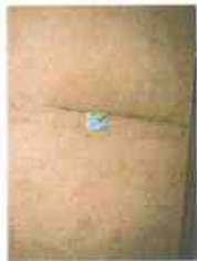
Asbestmateriaal
