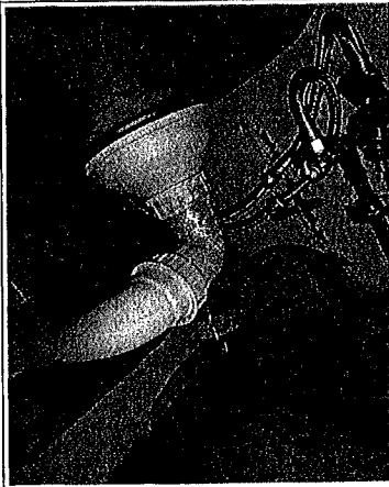
Foto 10: 182: gootsteen (met aanvoer van warm en koud drinkbaar water) - sifon van gootsteen in de keuken afgedicht met plakband
